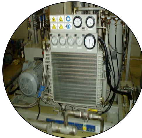
コンプレッサー
