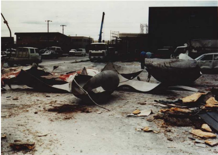
安全弁を閉止したためにタンクが爆発
