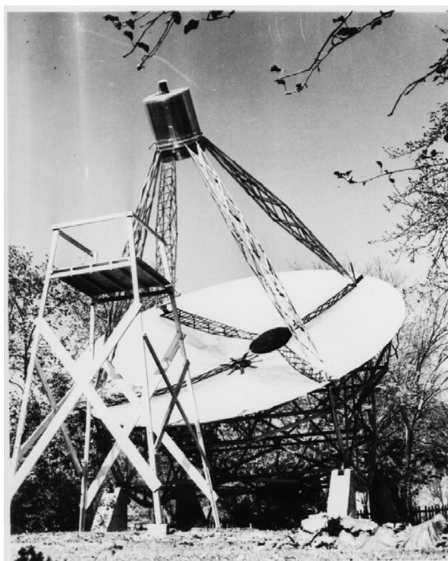
図6 Reberが自宅の庭に製作した世界初の電波望遠鏡。【出典：アメリカ合衆国国立電波天文台ホームページ】
